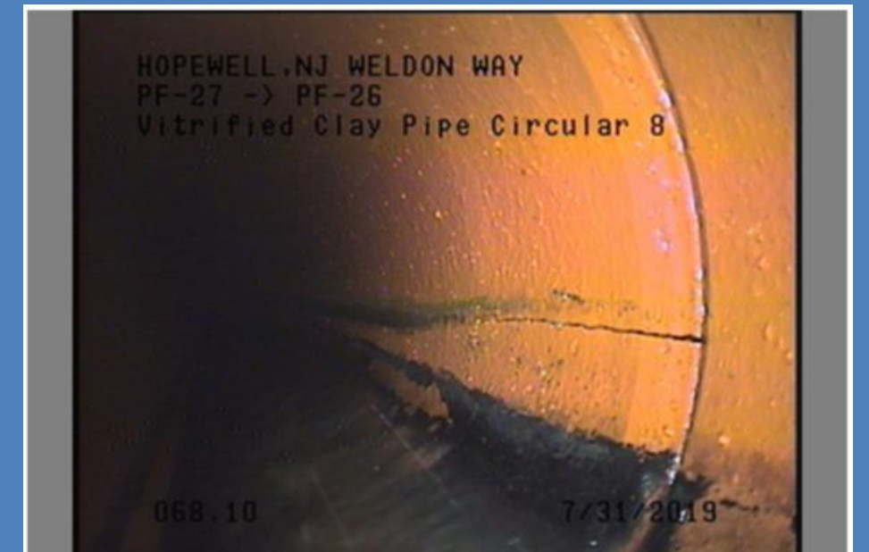
Longitudinal Fracture
